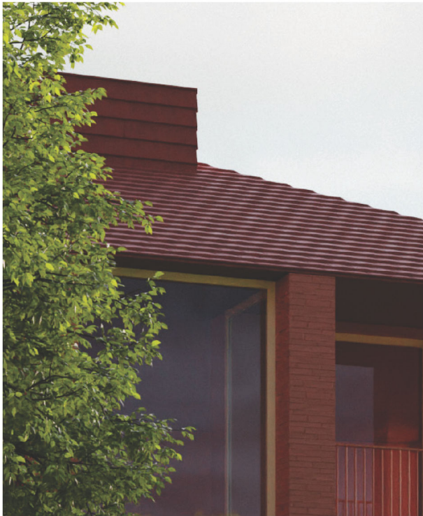
10. Periaate-esimerkki kattoharjan koteloinnista
