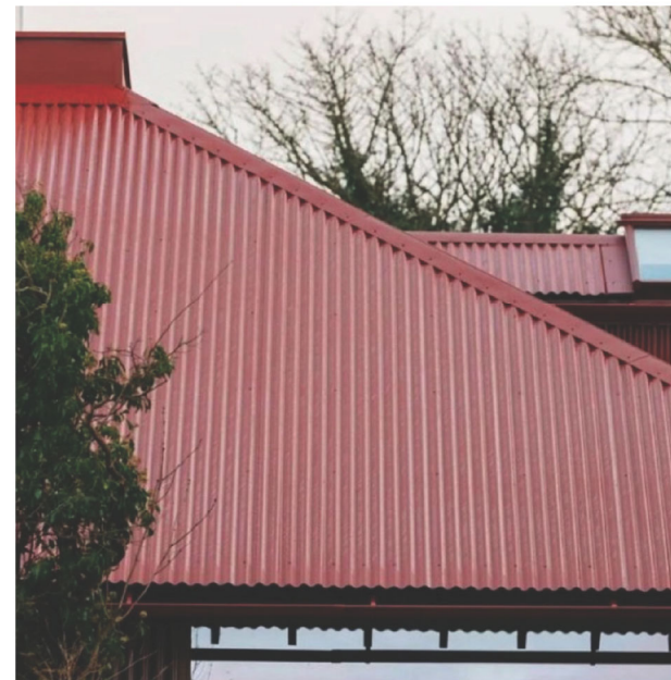
14. Esimerkki kapeasta poimupellisistä kattomateriaalina ja tavoitellusta räystäsdetaljiikasta.
